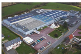
Roncey (Manche, 50) porte d'entrée et fenêtre PVC
